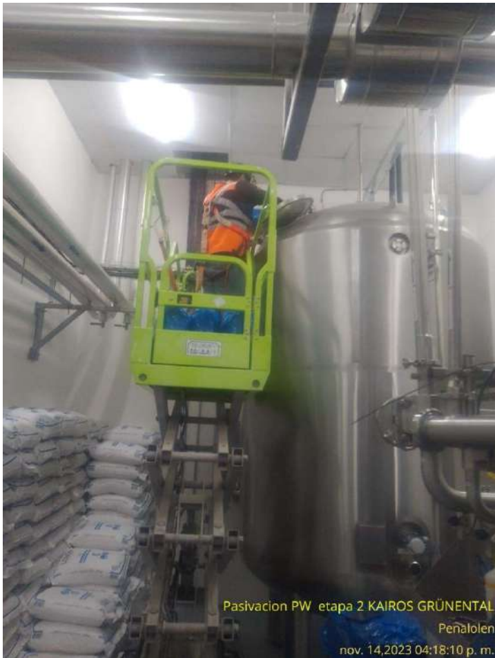
Vertido de ácido pasivante al tanque acumulador PW
